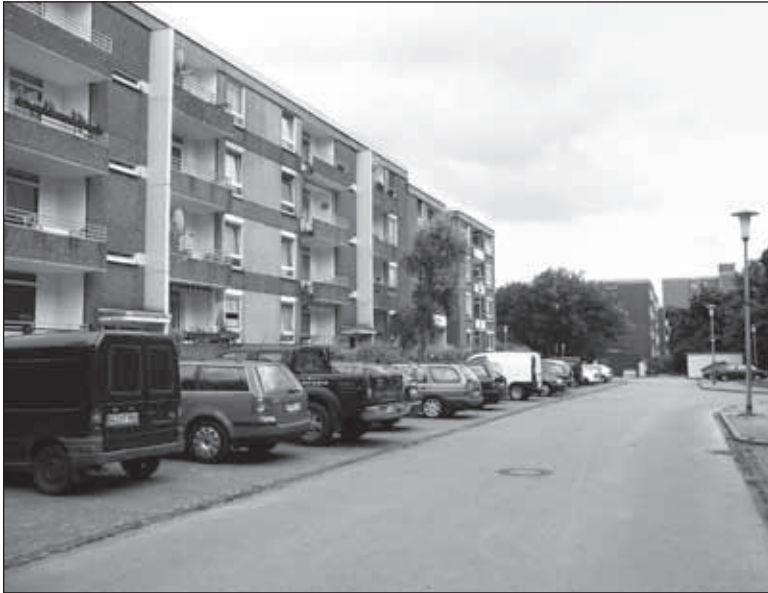
▲ Wohnhaus im Bergmannsfeld vor der Modernisierung. Foto: Christoph Wilmer.
