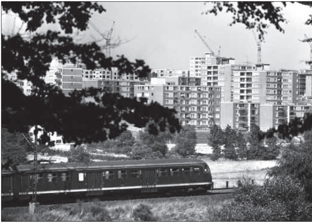
◀ Siedlung Bergmannsfeld im Bau, 1968. Foto: Stadt Essen, Stadtbildstelle.
